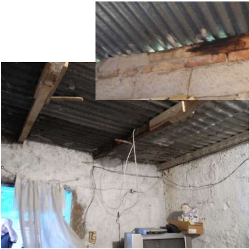
Techos de chapa sin cielorraso
