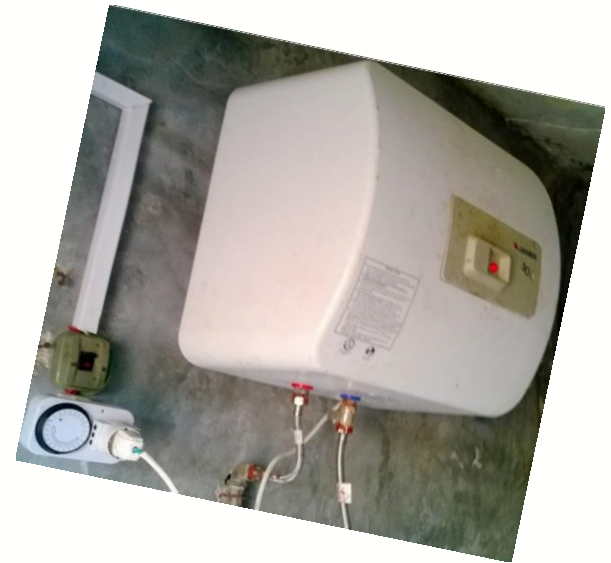
Sustitución de Termotanque y Timer
