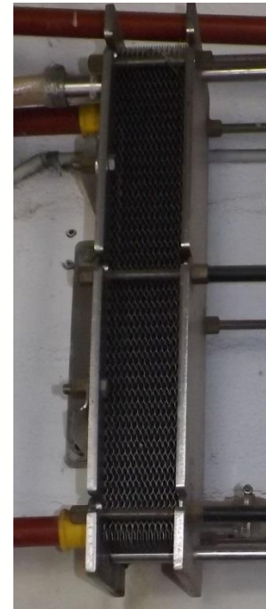
Intercambiador de Placas
